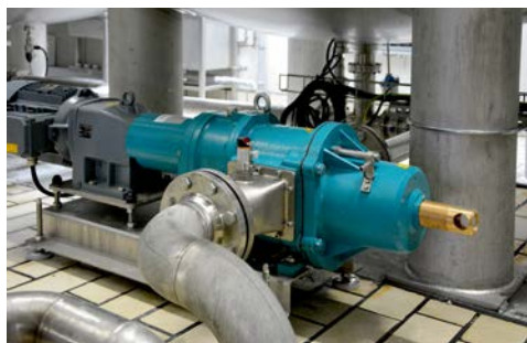
Роторно-лопастной насос и крышка с встроенным предохранительным клапаном, исполнены в соответствии со стандартами взрывозащиты АTEX.
